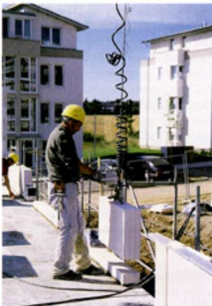
Bild 1. KS-QUADRO E beim maschinellen Vermauern
